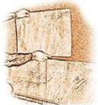
2 Installer et glisser la plaque **lamistone** jusqu'à sa place en laissant ou pas un effet joint entre les éléments.
